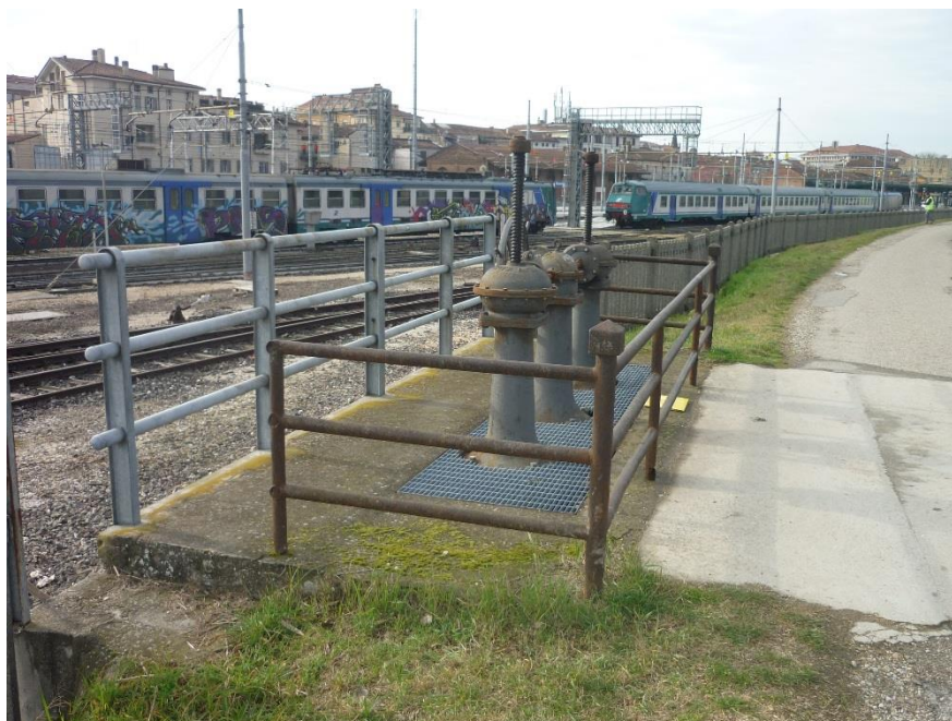
Figura 4-2: Paratoia di regolazione posta a valle della chiavica.
